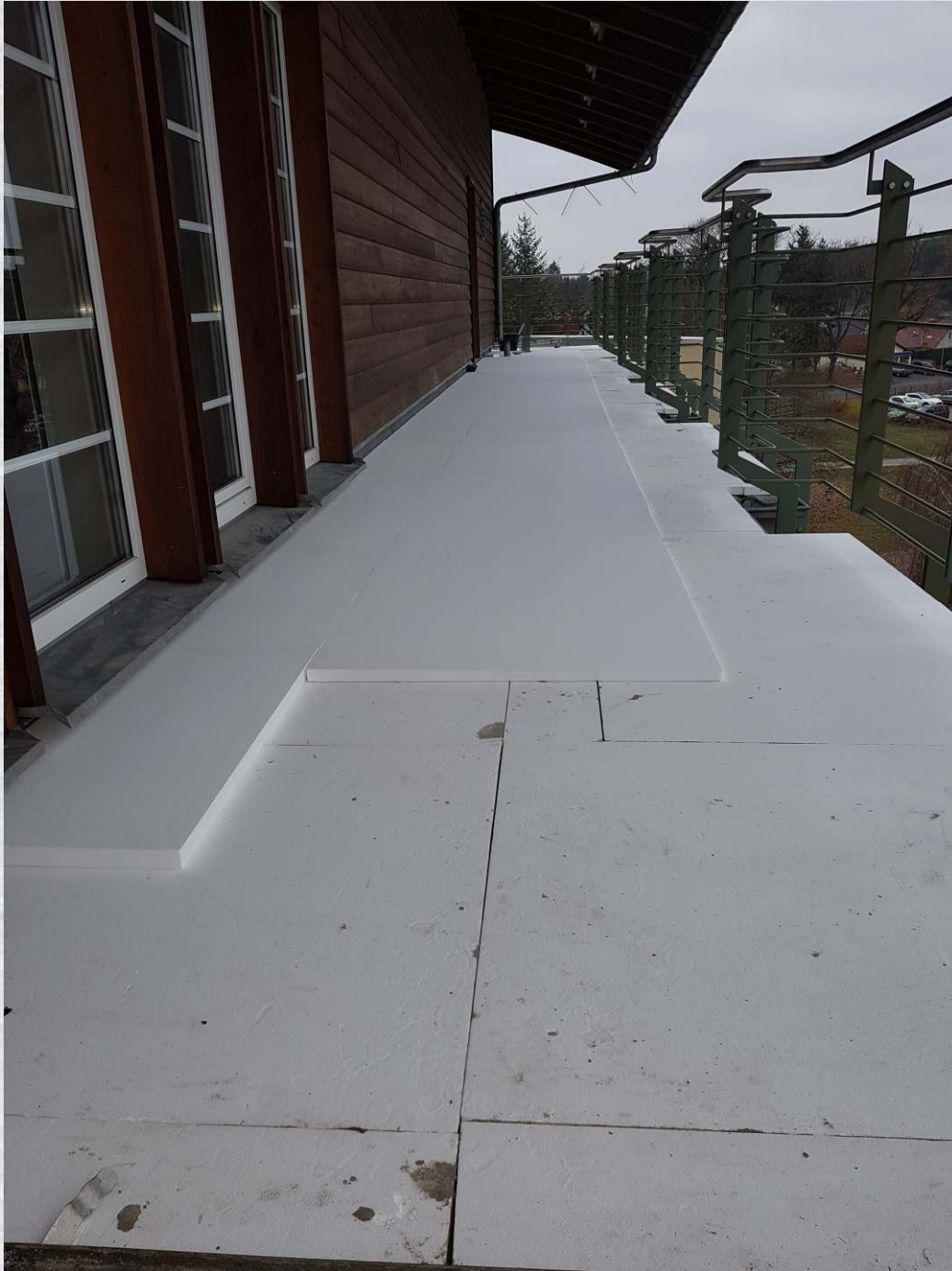
Neue Wärmedämmung mit Gefälleausbildung
